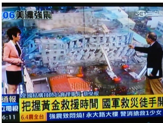
倒壊した17階建てのビル
